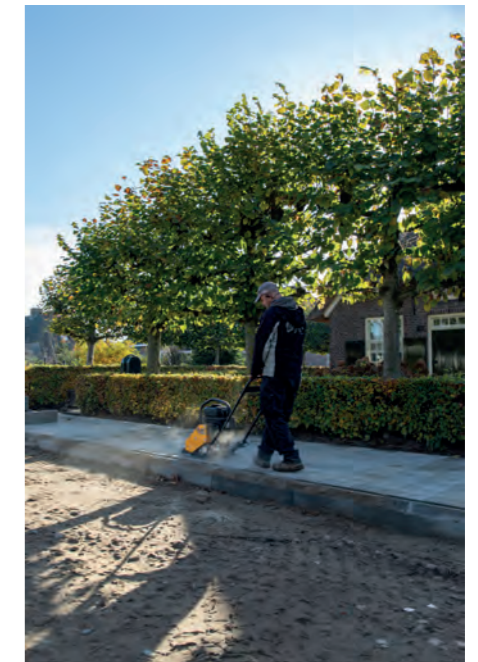
Emissievrij werken met de elektrische trilplaat
